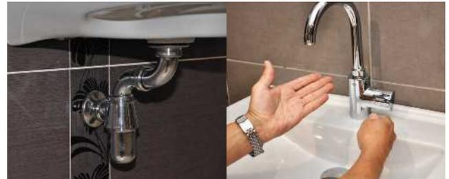
Un lavabo accessible présente un vide en partie inférieure d'au moins 0,30 m de profondeur, 0,60 m de largeur et 0,70 m de hauteur permettant le passage des pieds et des genoux d'une personne en fauteuil roulant. Le choix de l'équipement ainsi que le choix et le positionnement de la robinetterie permettent un usage complet du lavabo en position assise en veillant **notamment à la facilité de leur préhension.**
